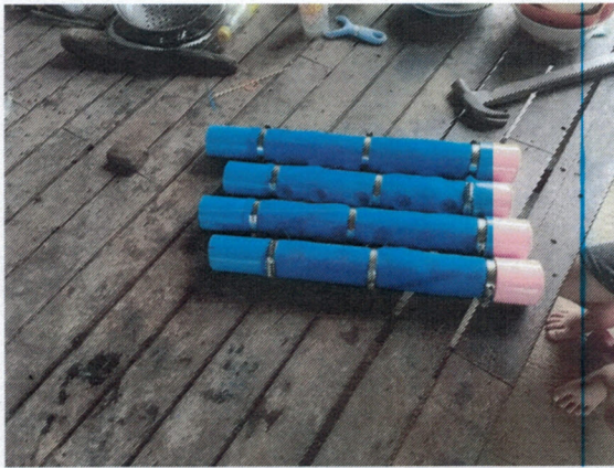
๒๔.จ้างเหมาซ่อมแซมระบบท่อกรองน้ำภายในถังกรองน้ำ หมู่ ๔ หนองยาว
