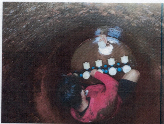
๒๔.จ้างเหมาซ่อมแซมระบบท่อกรองน้ำภายในถังกรองน้ำ หมู่ ๔ (ภายในอบต.ย่านยาว)
