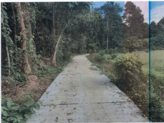
๓๑.ก่อสร้างถนน คสล.สาย ซี ๗๗ ม.๖
