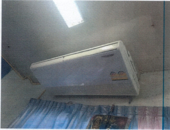
๒๒.จ้างเหมาซ่อมแซมเครื่องปรับอากาศ (สำนักปลัด)
