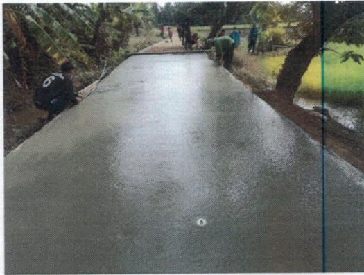
๓๐.ก่อสร้างถนนคสล.สายหนองอ้อทางแยก มด-ซอย๔ ม.๘
